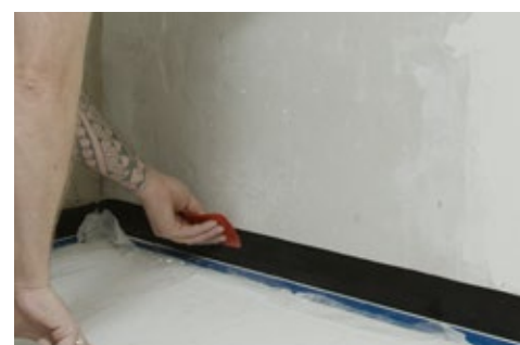
1. Wannendichtband verkleben
