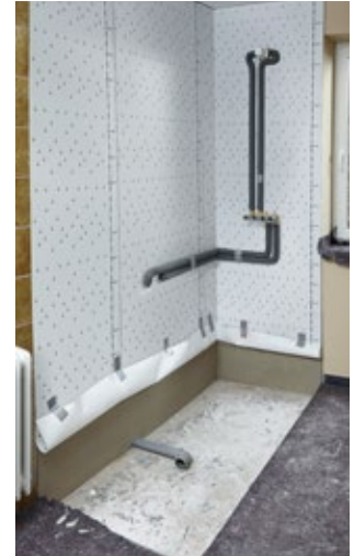
4. Leitungen installieren ggf. versetzen
